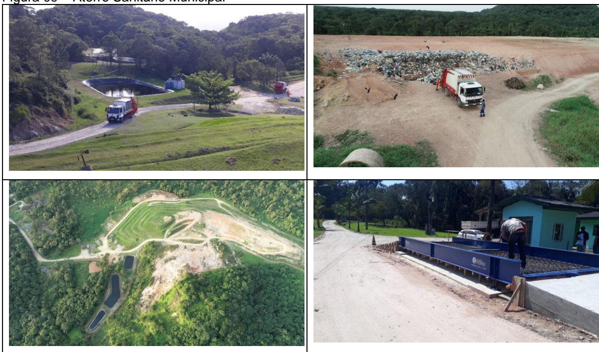
Figura 09 – Aterro Sanitário Municipal
