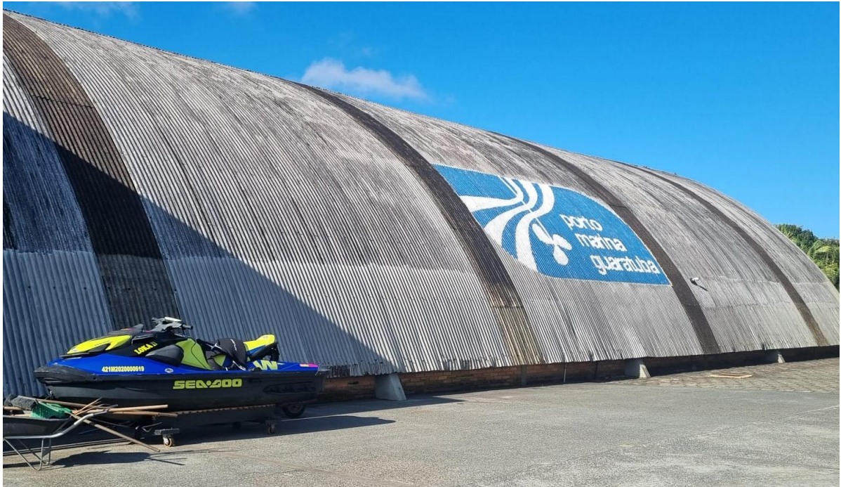
Figura 21 – Hangar coberto para barcos existente. Fonte: Porto Marina, 2024.
