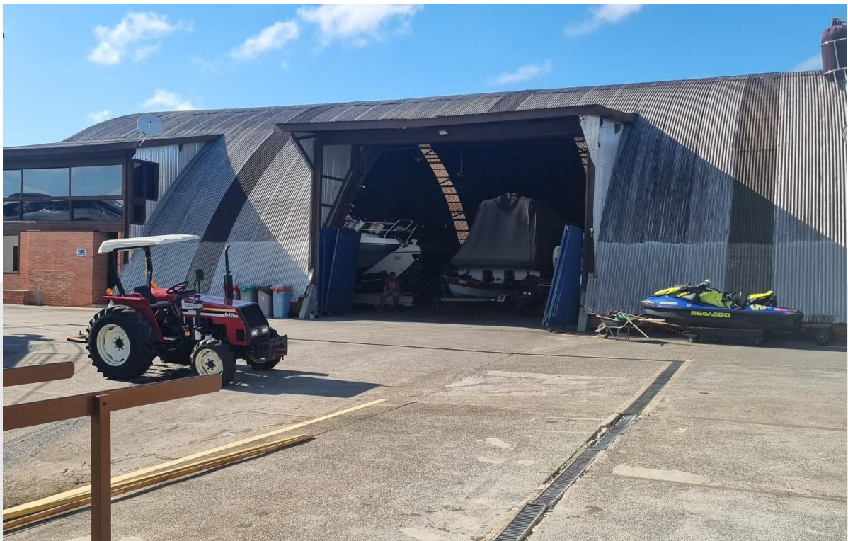
Figura 22 – Hangar coberto para barcos existente. Fonte: Porto Marina, 2024
