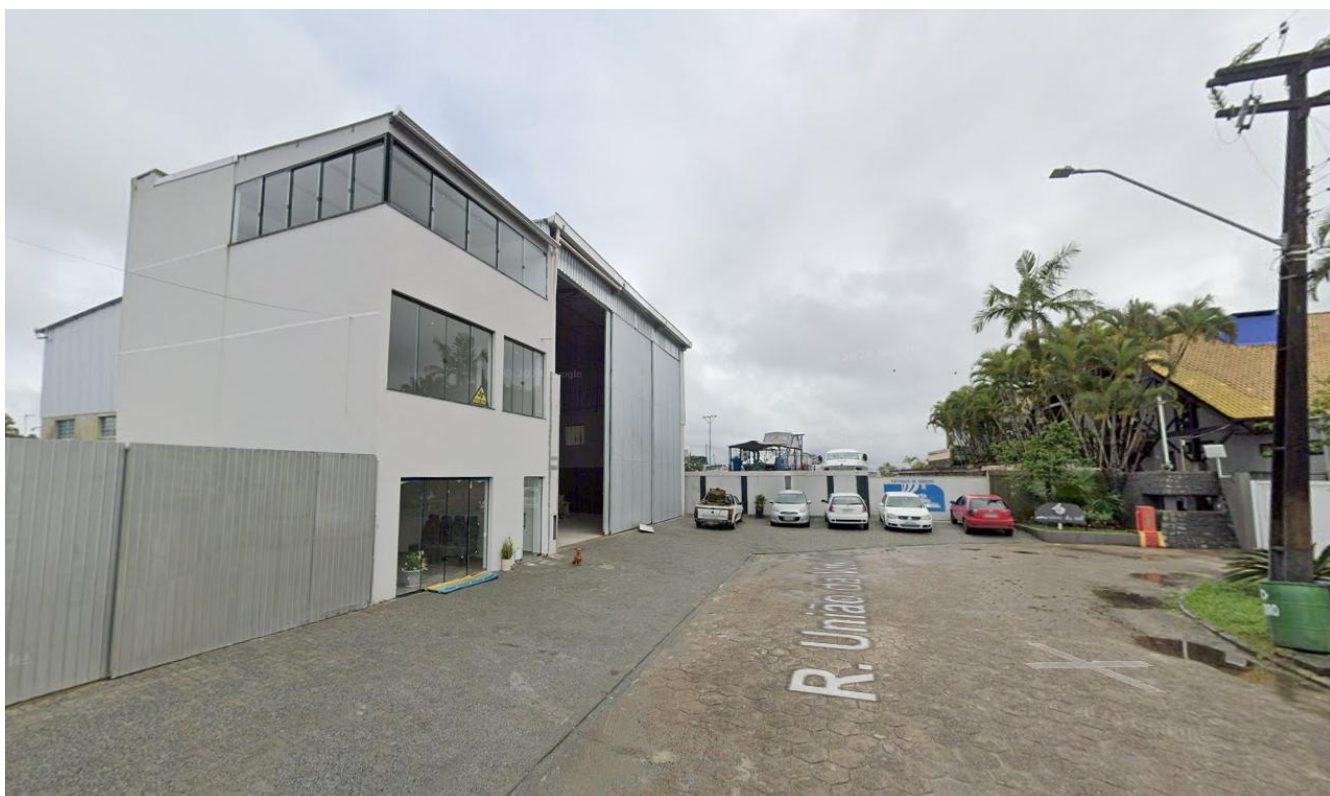
Figura 19 - Vista da Rua União da Vitória, acesso ao empreendimento de oficina de conserto de barcos. Fonte: Google Street View, 2023.
