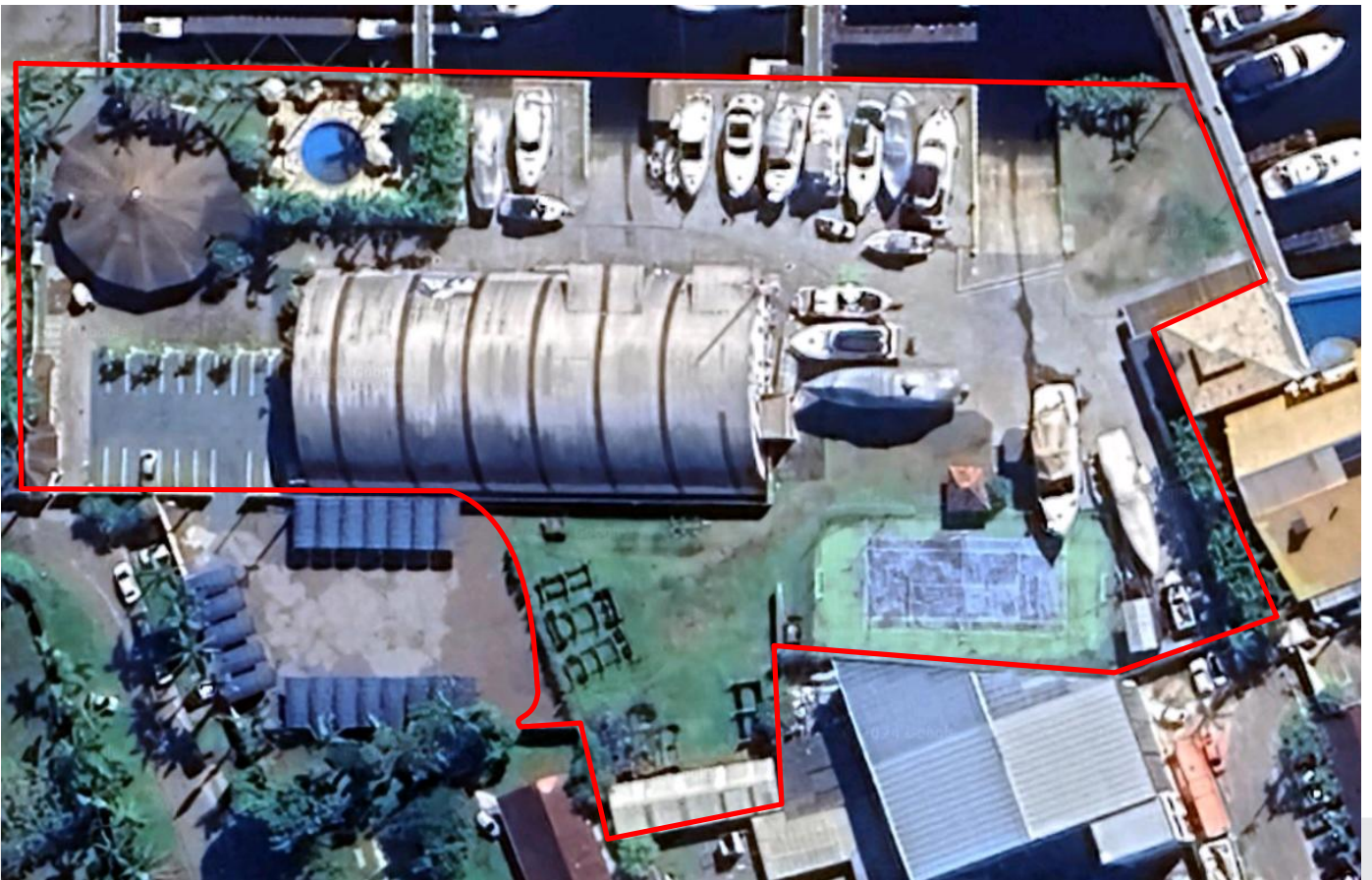
Figura 04- Imagem aérea do empreendimento existente. Fonte: Google Maps, 2024, editado por SYDOR arquitetura, 2024.
