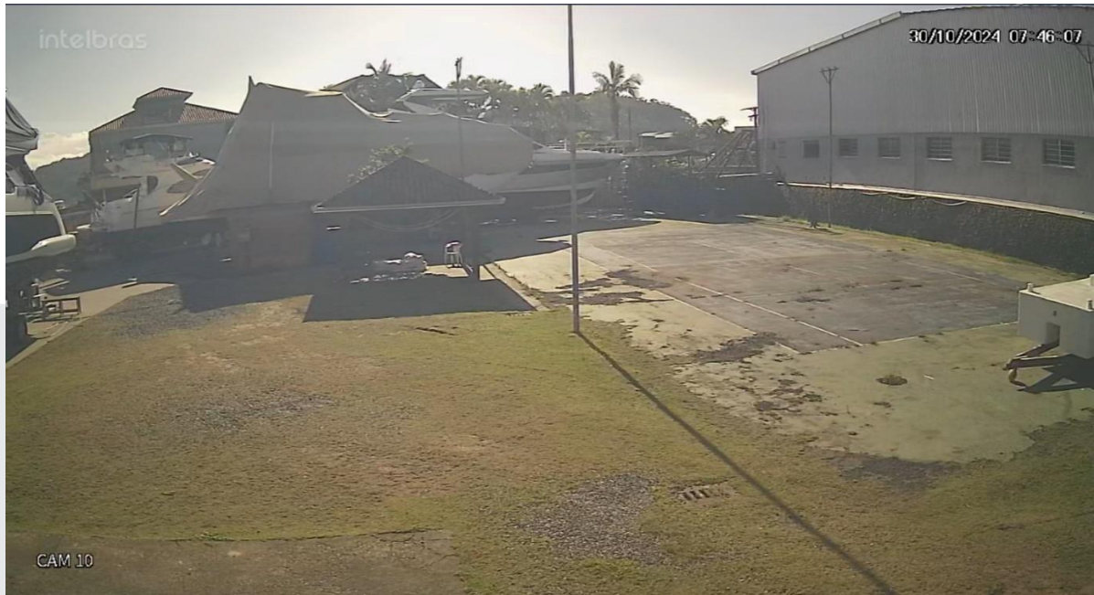
Figura 28 –Área onde será construído o novo hangar coberto para barcos. Fonte: Porto Marina, 2024
