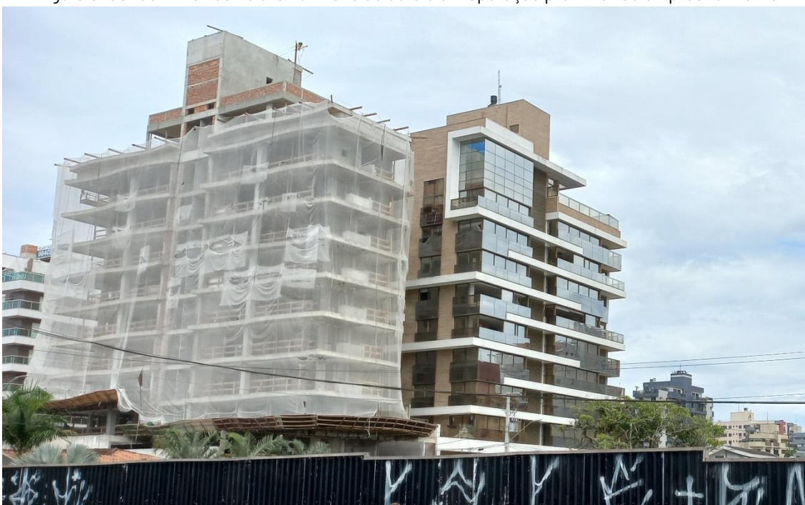
Figura 9. Condomínios correlatos em fase de obra e em operação próximos ao empreendimento
