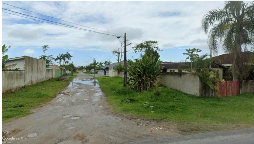
Figura 08 – Av. Santa Clara - Via sem calçada. Fonte: Google Street View, 2023.
